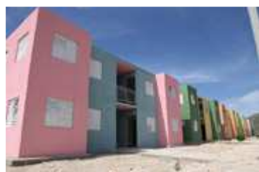
Un ensemble de logements d'ONU Habitat à Port-au-Prince, Haïti. Photo: ONU-Habitat
