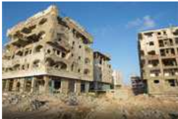
Des bâtiments bombardés à Aden, au Yémen. Photo PAM/Ammar Bamatraf
