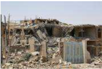
Des maisons détruites par des frappes aériennes dans la capitale Sana'a, au Yémen, en juillet 2015. Photo OCHA/Charlotte Cans
