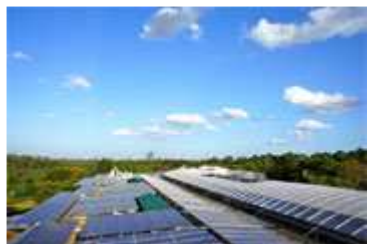
Un système d'énergie solaire d'ONU Environnement - le plus grand de ce type en Afrique. Photo: PresseBox.de Flickr
