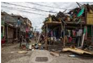
Le cyclone Matthew a frappé Haïti en octobre 2016 causant des dommages importants dans les villes de Jeremie et les Cayes, à l'ouest du pays. Photo: ONU/MINUSTAH/Logan Abassi
