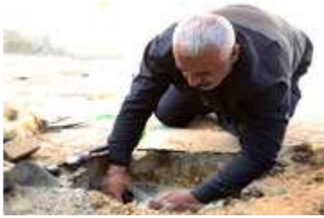
Réparation d'une système d'alimentation en eau dans le camp de Jabalia, dans le nord de Gaza. Photo: UNRWA/Khalil Adwan
