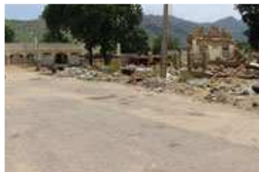
La ville de Gwoza, dans l'Etat de Borno, dans le nord-est du Nigéria, a été rasée durant le conflit avec Boko Haram. La tâche à venir est de reconstruire les infrastructures de base, les hôpitaux, les écoles, l'alimentation en eau et les dispositifs sanitaires, et des refuges qui demandent un financement. Photo: OCHA/Orla Fagan
