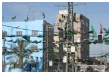
Lignes à haute tension à Gaza. Photo: Banque mondiale/Natalia Cieslik
