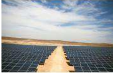
La ferme solaire du camp de réfugiés d'Azraq, en Jordanie. Photo IKEA Foundation/Vingaland AB
