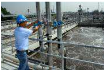
station de traitement des eaux usées à Manille, aux Philippines. Photo: Danilo Pinzon / Banque mondiale
