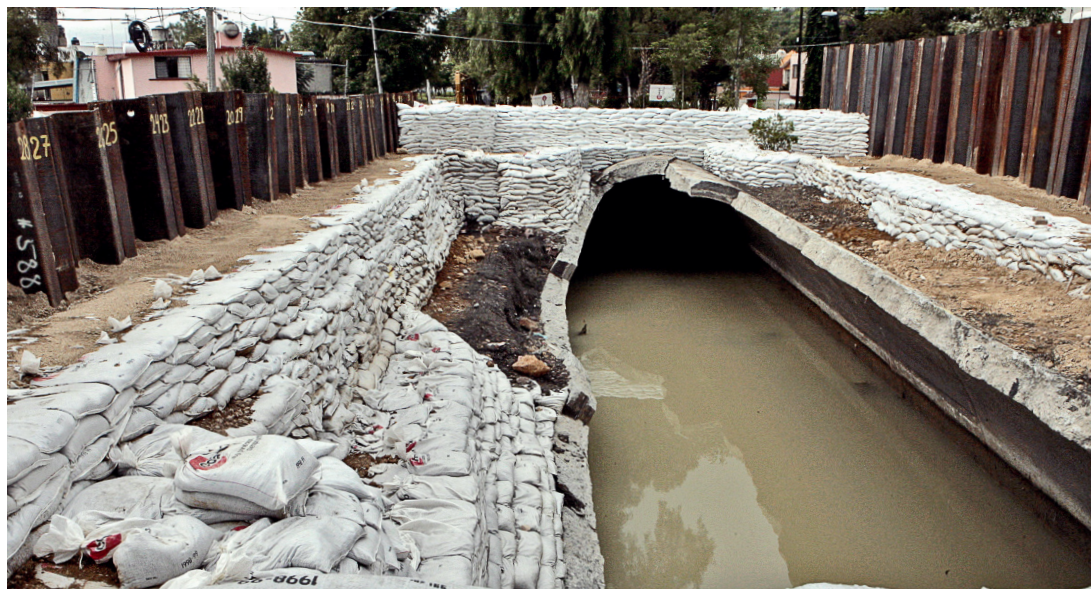
> La Conagua repara el Emisor Poniente que se fracturó el 6 de septiembre por las intensas lluvias. La falla generó una inundación en Valle Dorado que causó pérdidas económicas por más de 197 millones de pesos.
