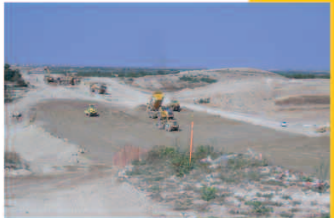
Canal Segarra-Garrigues. Tramo: IV. Verdú, Lérida.
