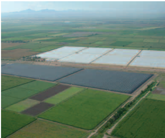
Fig. 7. Modernised irrigation infrastructure. Sinaloa (Mexico). Source: Novedades Agrícolas.
