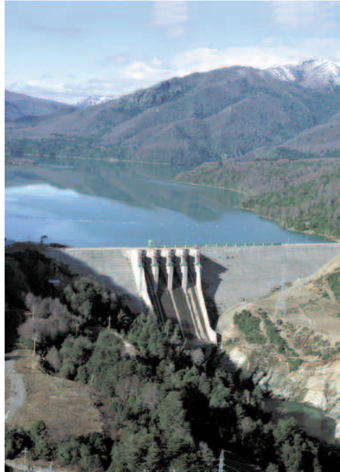
Fig. 12. Panguel dam (Chile). Source: Endesa.
