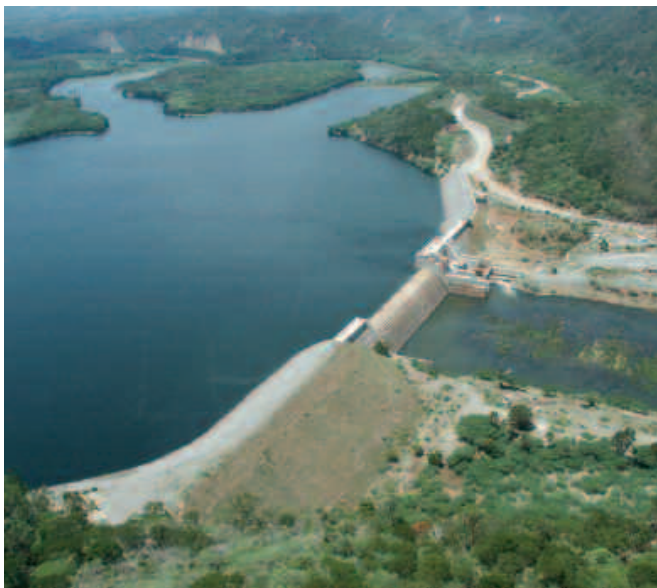
Fig. 5. Monción Contraembalse dam (Dominican Republic). Source: Ferrovial Agromán.
